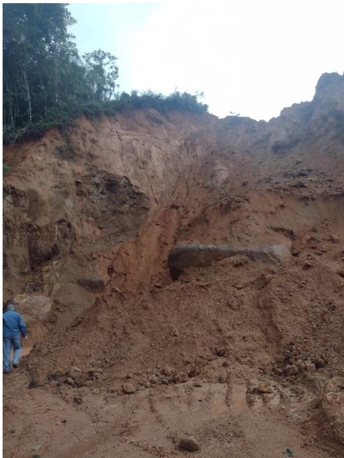
Figura 14 – Talude na área do saibro, com 9 m de altura e 21° de inclinação.
